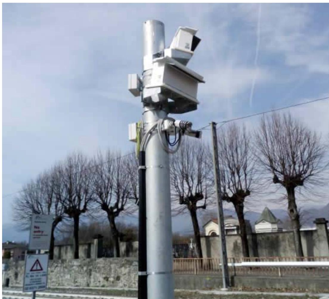
Il PAI PL dovrebbe risolvere i problemi di sicurezza nel caso in cui automobili, ciclisti o pedoni dovessero rimanere bloccati tra le sbarre abbassate dell'attraversamento ferroviario. Se dovesse capitare che un ostacolo impedisce il passaggio del treno sui binari, i sensori entrano in azione avvisando in tempo il
